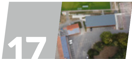
17 Raum für Bewegung & Begegnung Unser Neubau am Volksbank Sportpark
